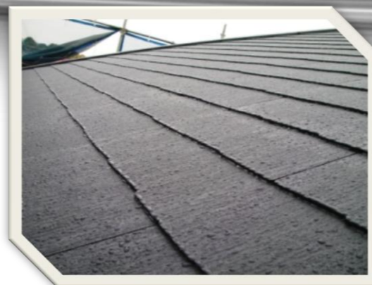
* カラーベスト施工済み (雨天時の画像)
